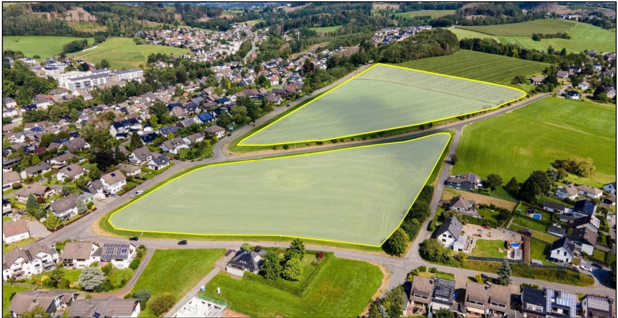
Foto 1: Flächen (gelb markiert) für das geplante Wohnbaugebiet im umliegenden Straßennetz (Eigene Aufnahme)
