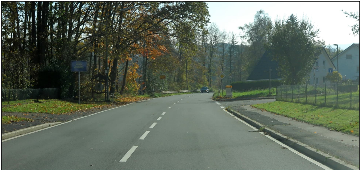
Foto 25: Engelskirchener Straße / Talstraße (KP 15) (Blickrichtung Süden) (Eigene Aufnahme)
