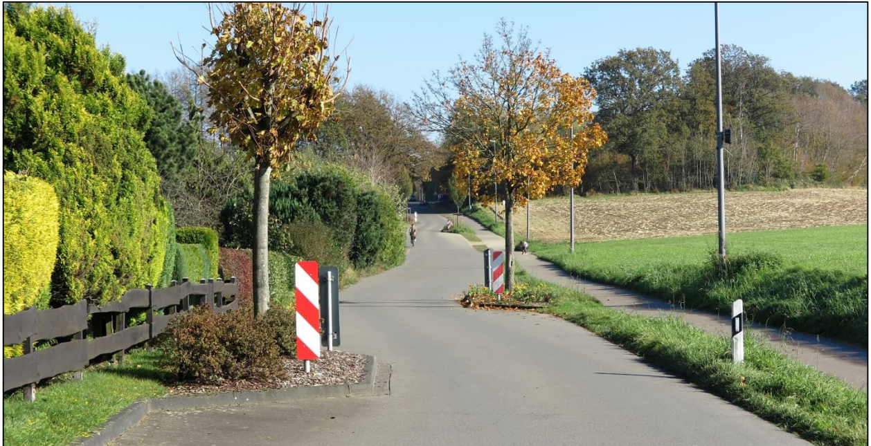
Foto 16: Bauliche Verringerung des Straßenquerschnitts Jugendherberge (QS 2) (Eigene Aufnahme)
