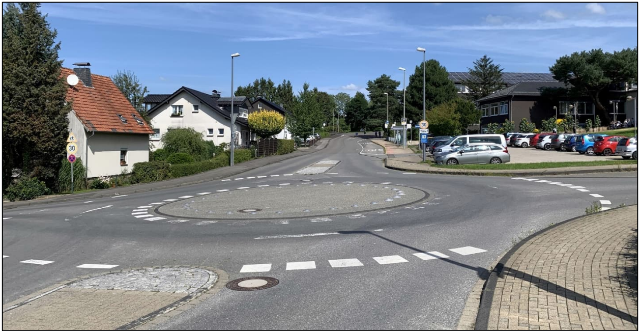
Foto 6: Wilhelm-Breidenbach-Weg / Voßbrucher Straße / Carola-Lob-Weg (KP 2) (Eigene Aufnahme)
