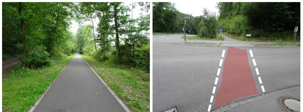
Abb. 48 Bahntrassenradweg; fehlende Furtmarkierung (rechts)
