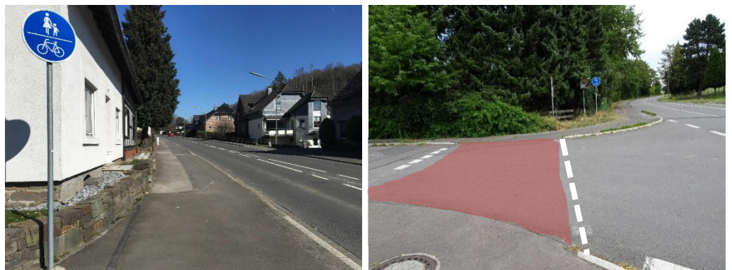
Abb. 54 Klauser Straße (K 21); fehlende Furtmarkierung (rechts)
